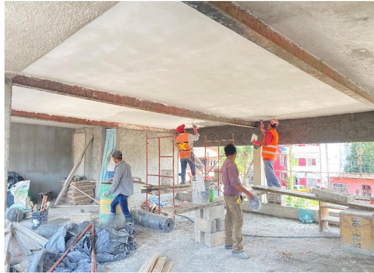
Colocación de aplanado Fino en plafón y aplicación de sellador.
