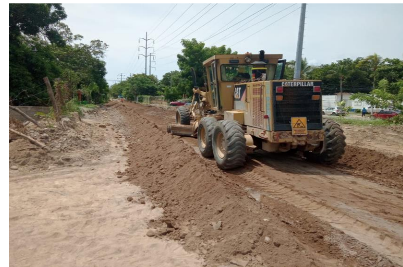
T-5 Conformación de base para desplante de terraplén
