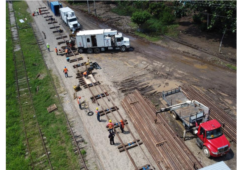
Soldadura de riel (Roberto Ayala Pk 127+800)
