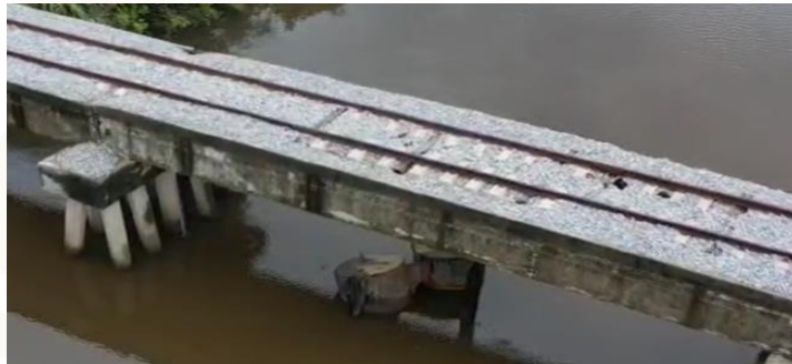
Trabes de concreto (219 puentes)
