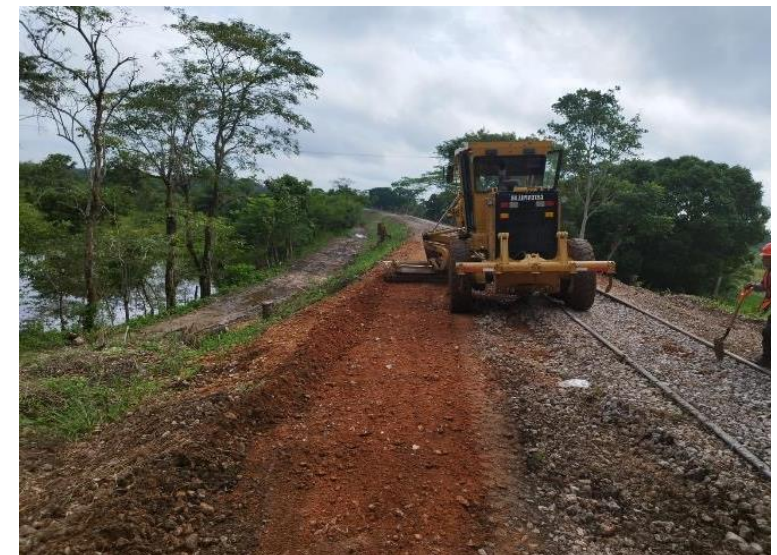
Ampliación de corona de terracerías PK 129+100
