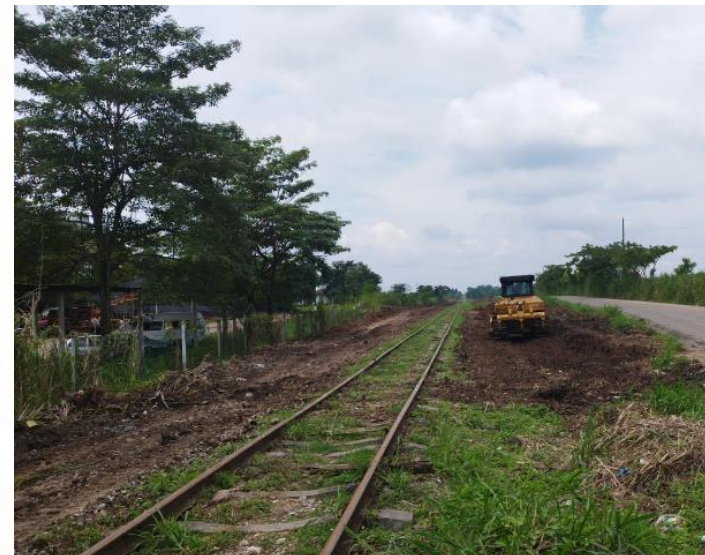
Desmote y despalme PK 123+100
