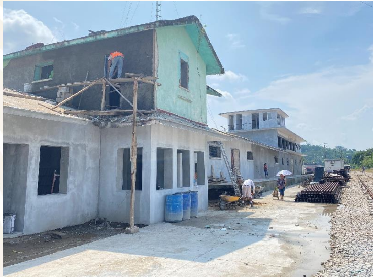
Modernización de estación de vía en Teapa, Tab.
