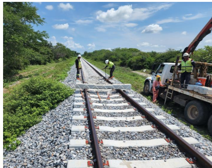
T-4 Sustitución de durmientes Z-266+350
