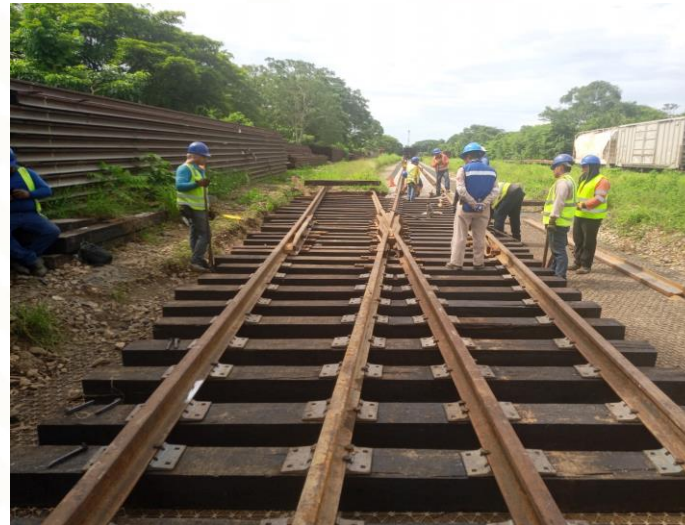
T-1 Armando cambio de vía 96+400
